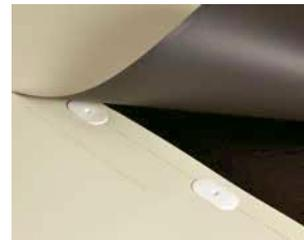
Il est recommandé de ne pas entamer immédiatement les travaux de fixations et d'assemblage des lés afin de permettre la relaxation initiale de la membrane ( $\pm 15$  minutes).
