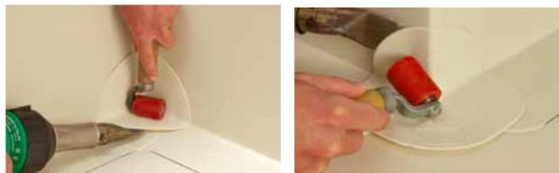
Dans les deux cas, la pièce doit être soudée sur la membrane de base et le relevé avec une soudure effective d'au moins 30 mm.
