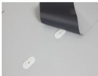
Les lignes de fixations intermédiaires ainsi créées sont recouvertes d'une bande de RENOLIT ALKORTOP de la même épaisseur que la membrane de base et de largeur minimale 200 mm. La bande est soudée de part et d'autre avec les techniques décrites ci avant.
