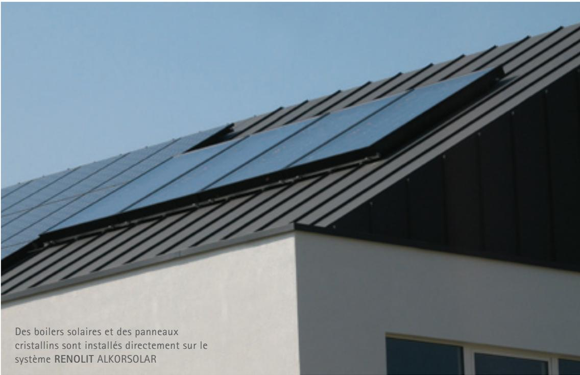
Des boîlers solaires et des panneaux cristallins sont installés directement sur le système RENOLIT ALKORSOLAR
