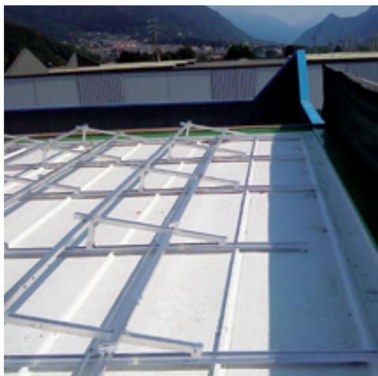
RENOLIT ALKORSOLAR - la fijación de sus paneles solares sin perforación de la estanqueidad.
