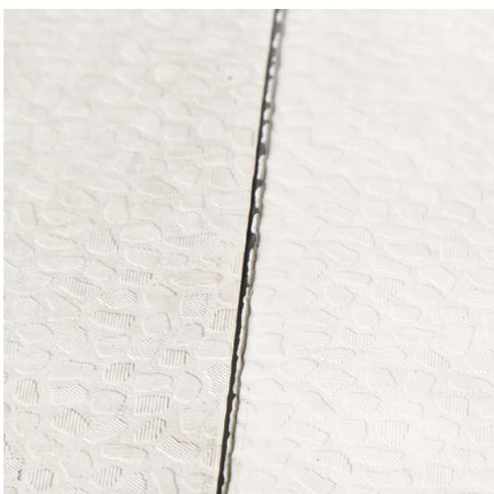
В процессе укладки стандартной белой кровельной мембраны сварные швы выделяются над белой поверхностью кровли.
