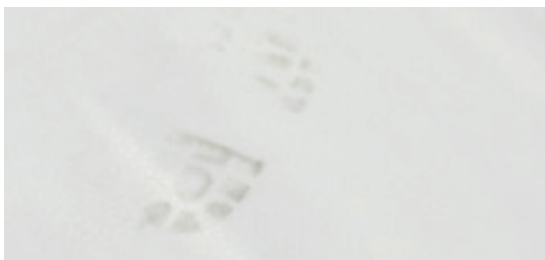
Vuile voetstap veroorzaakt door plaatsing.
