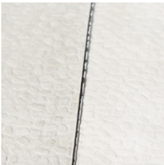
Bij verwerking van een witte dakbaan met een grijze onderlaag vallen de lasnaden duidelijk op in het dakoppervlak.
