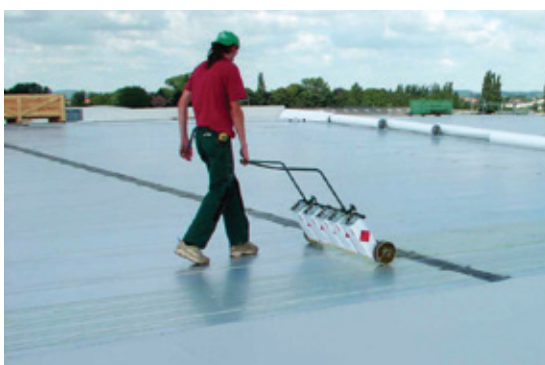
Fig 1: Aplicación del adhesivo 81068 con carro
