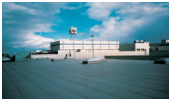
Usine BMW ( Allemagne)
