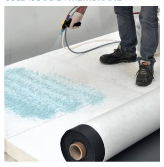
La colle RENOLIT DUALFIX est pulvérisée au pistolet sur la surface de l'isolant. Puis, la membrane est déroulée et pressée sur la colle avant séchage.
