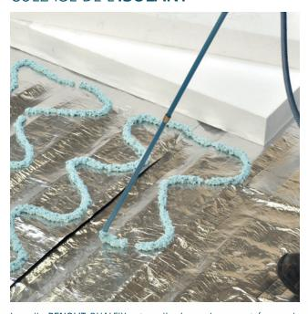
La colle **RENOLIT** DUALFIX est appliquée sur le support (ou sur le pare-vapeur) en cordons à l'aide de la buse de projection. Les panneaux d'isolant sont ensuite positionnés et pressés sur les cordons de colle encore frais.
