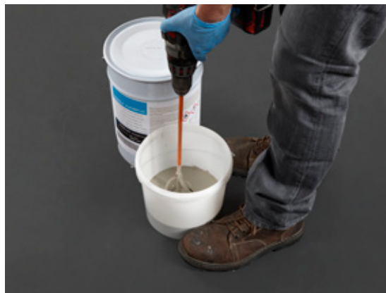
4. Mélangez consciencieusement (2 à 5 minutes, en fonction de la température).
