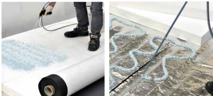
Нанесение клеевого состава RENOLIT ALKORPLUS 81065
