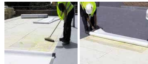
Нанесение клеевого состава RENOLIT ALKORPLUS 81068
