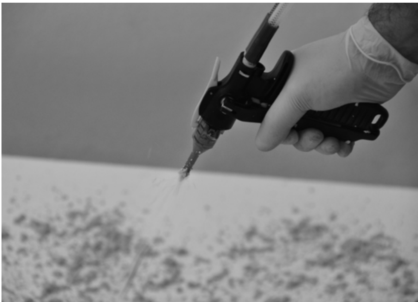
Aplicación del adhesivo RENOLIT DUALFIX
