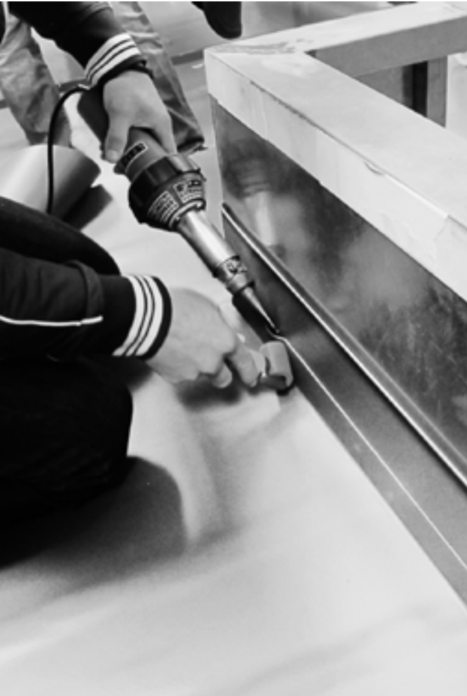
Conexión al perfil colaminado
