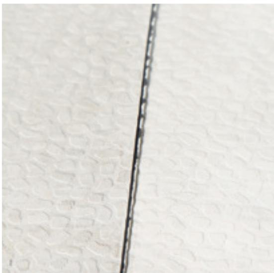
En el caso de las membranas de estanqueidad con capa inferior gris o negra, las soldaduras son muy visibles.
