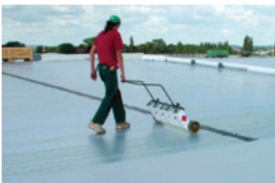
Fig 1: Aplicación del adhesivo 81068 con carro
