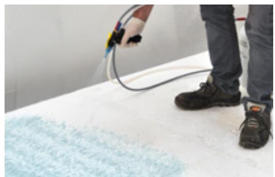
Fig 2: El adhesivo 81065 se pulveriza sobre la superficie a través de la pistola aplicadora
