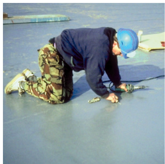
Fig.2: Controle van de lasnaden.
