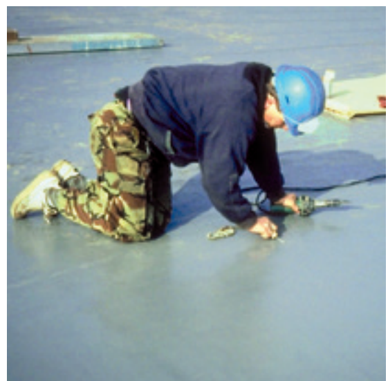
Fig.2: Control de las soldaduras
