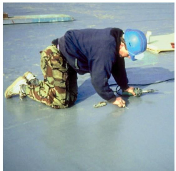
Fig.2: Control de las soldaduras
