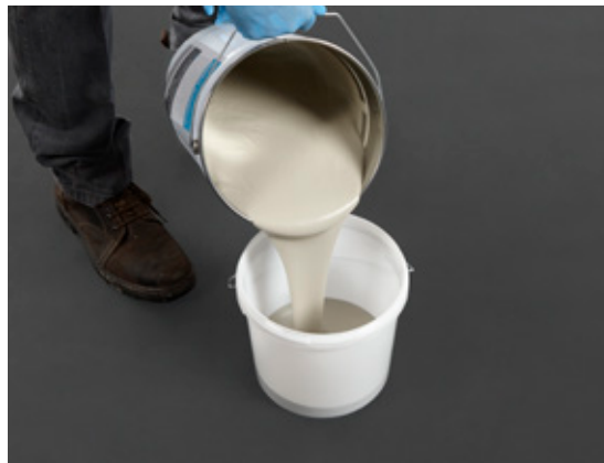
2. Determina la quantità necessaria di resina o primer necessario. Non miscelare più materiale rispetto alla quantità che può essere applicata entro il periodo di indurimento.
