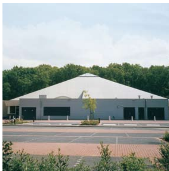
Schwimmbad Jasperweg (Die Niederlande)
