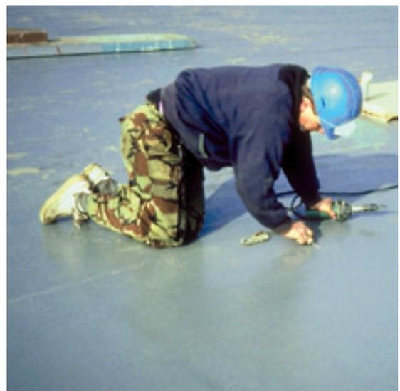
Abb. 2: Kontrolle der Schweißnähte.
