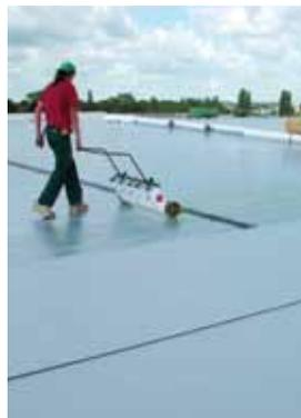
Fig. 1: Verklebung mit dem Auftragswagen
